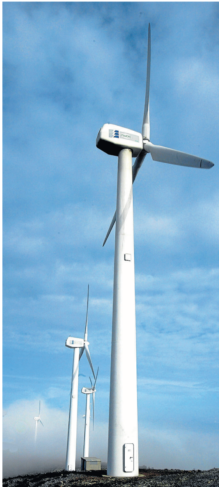
Uno de los parques eólicos de la provincia. LUIS ANGEL TEJEDOR
